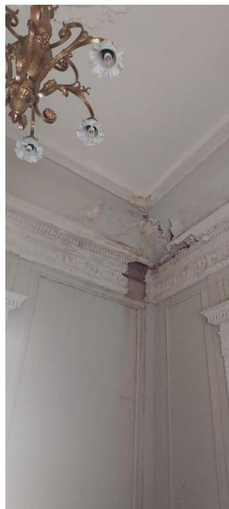
Danos causados por infiltrações no telhado
