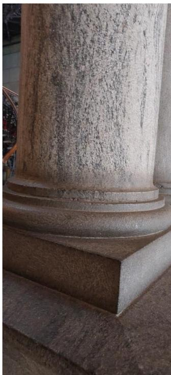
Detalhe da coluna com sujidade aderida
